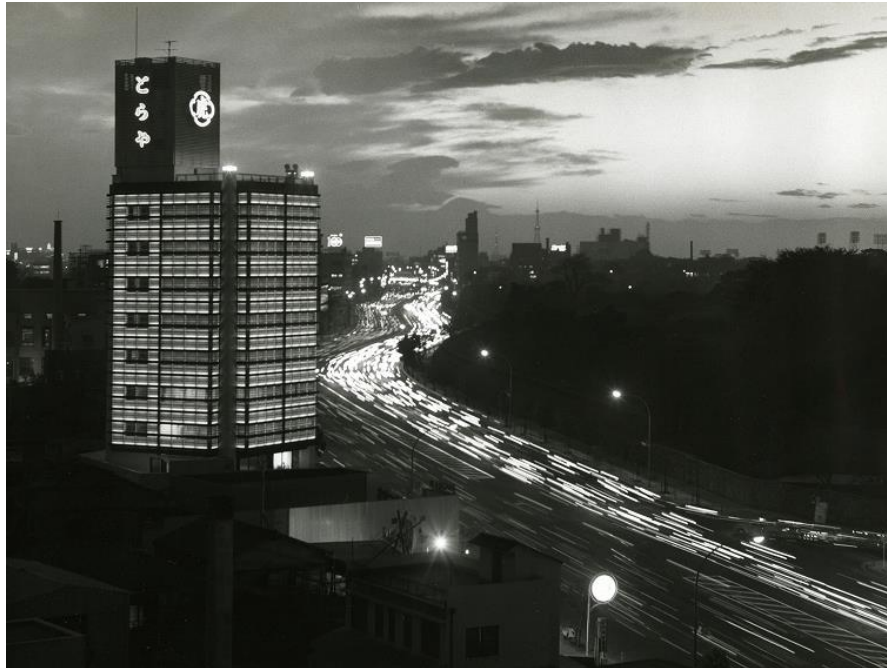
昭和 39 年（1964）虎屋ビル
